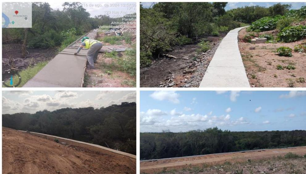
Figura 50 - Construção de muro de gabião e vala de drenagem perimetral do lixiviado
