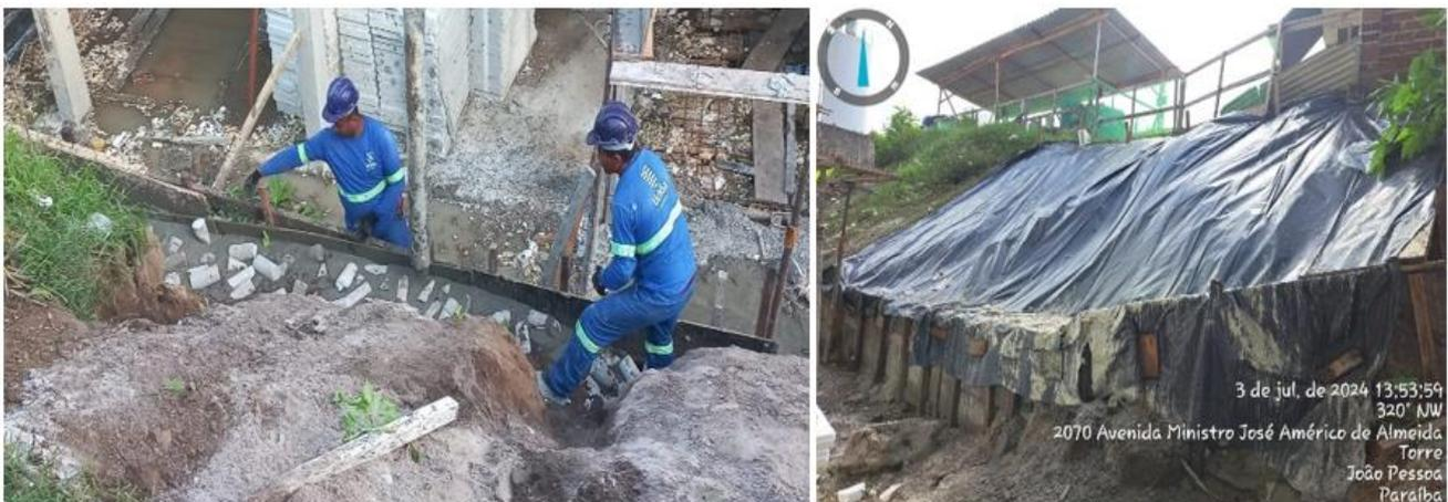
Figura 57 - Processos erosivos solucionados nas obras do Terreno 3
