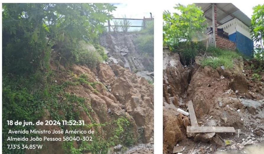
Figura 46 - Processos erosivos identificados nas obras do Terreno 3.
