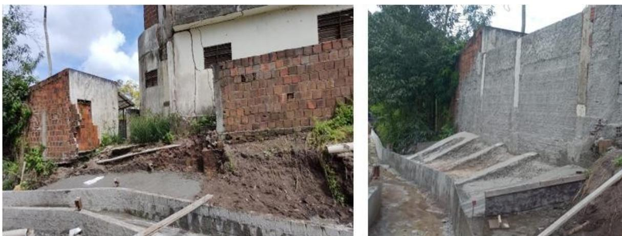
Figura 50 - Dano ocorrido no muro do vizinho ao lado do Terreno 3.
