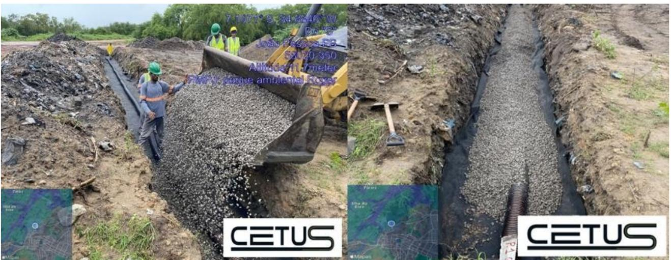
Figura 37 - Execução de vala de drenagem de biogás.
