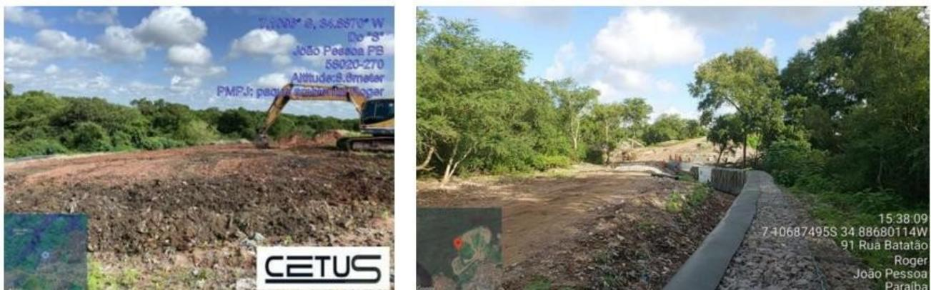
Figura 51 -Execução do reperfilamento e muro de gabião.
