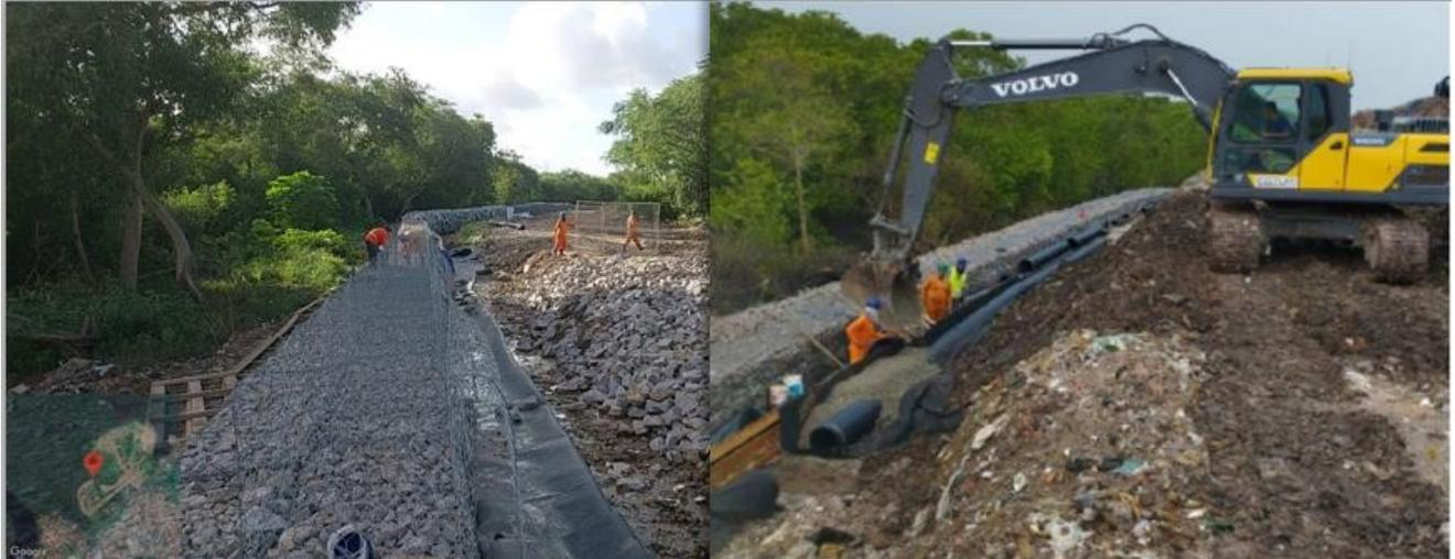
Figura 36 - Construção de muro de gabião e vala de drenagem perimetral do lixiviado
