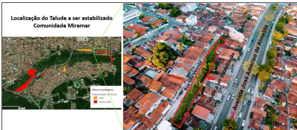
Figura 15 - Localização do Talude a ser estabilizado.
