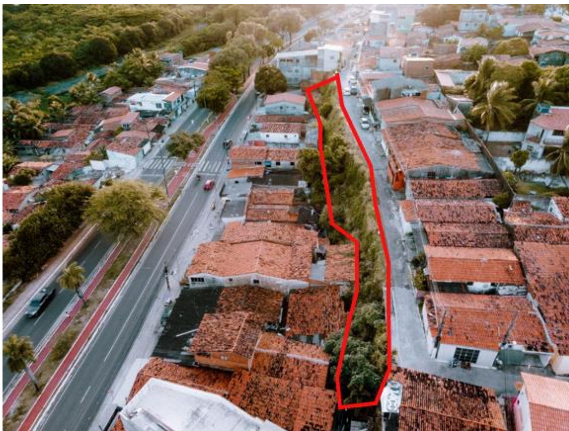
Figura 10 – Vista superior da encosta miramar, adjacente à Rua São Vicente.
