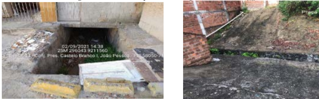
Figura 140 - Construções sobre dispositivos de drenagem
