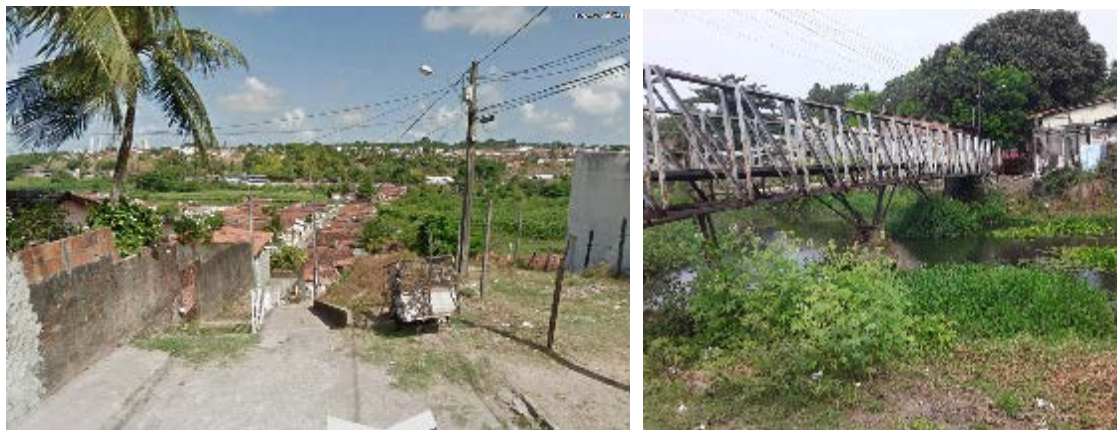
Figura 115 - Acesso a Comunidade pela Avenida Adolfo Cerne (à direita) e pela ponte de ligação entre as Comunidades São Rafael e Padre Hildon Bandeira.
