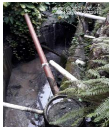
Figura 148 - Casa construída sobre galeria de drenagem (à esquerda); lançamento clandestino de esgoto (à direita).
