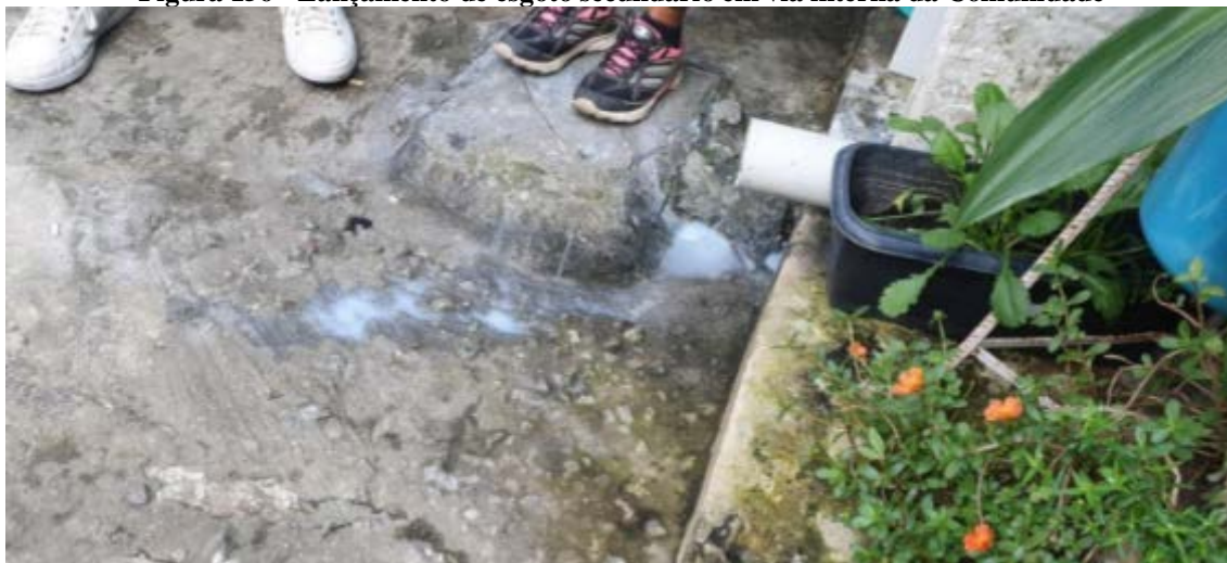
Figura 156 - Lançamento de esgoto secundário em via interna da Comunidade
