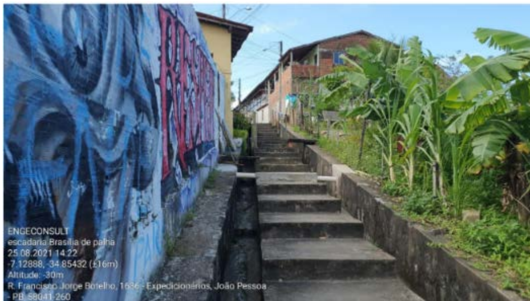
Figura 124 - Canalização na lateral da escadaria de acesso à Av. Beira Rio.
