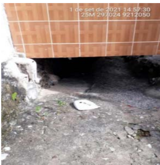
Figura 148 - Casa construída sobre galeria de drenagem (à esquerda); lançamento clandestino de esgoto (à direita).
