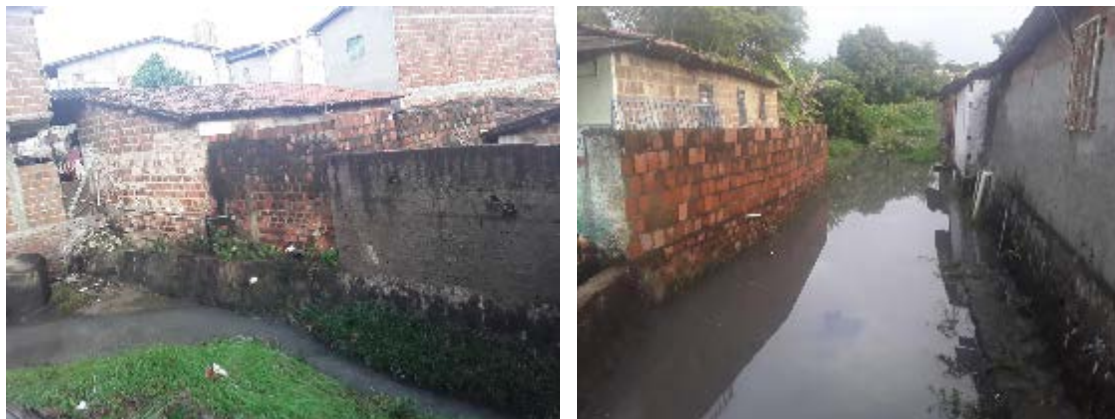
Figura 162 – Notória contaminação do Rio Jaguaribe com lançamento de esgoto.
