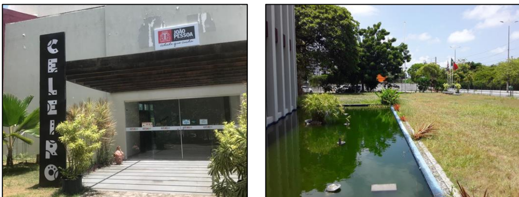
Figura 8 – Parte frontal da edificação na ADA.
