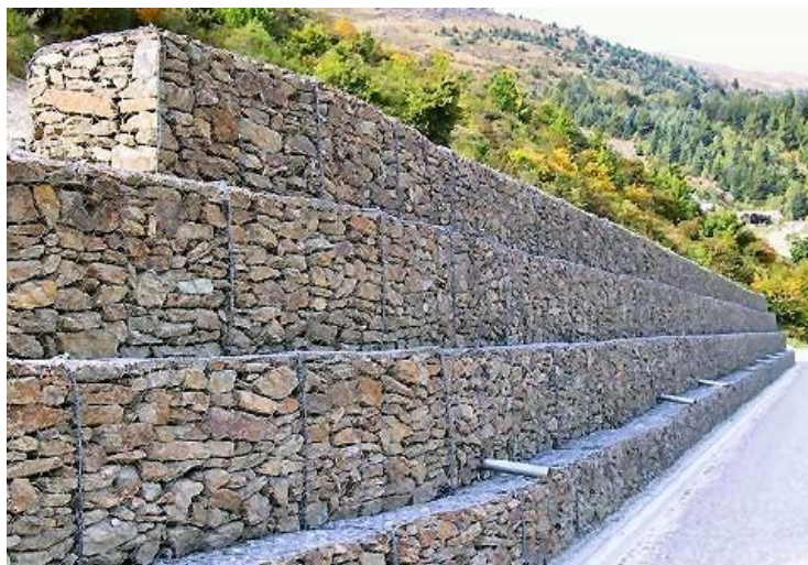
Figura 14 – Representação de Muro de Gabião.
