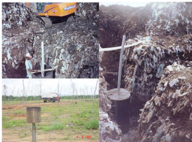
Figura 13 – Drenagem e queimadores de gases instalados.
