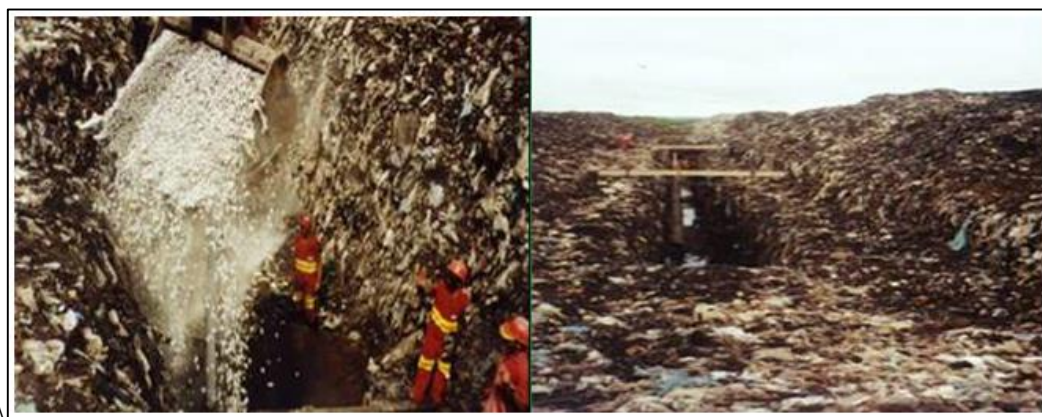
Figura 12 - Abertura das valas de drenagem do chorume/percolado.
