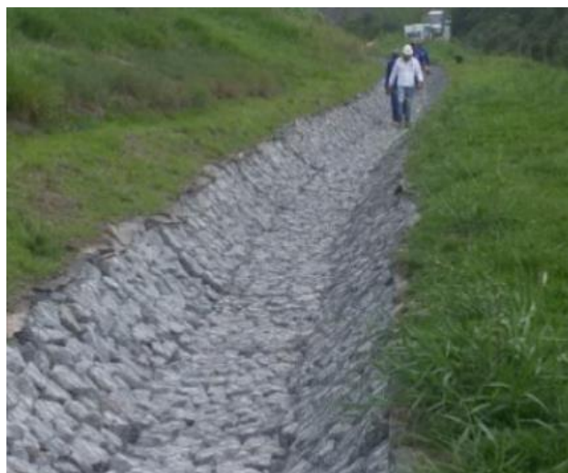
Figura 19 – Exemplo de descida hidráulica em colchão Reno.
