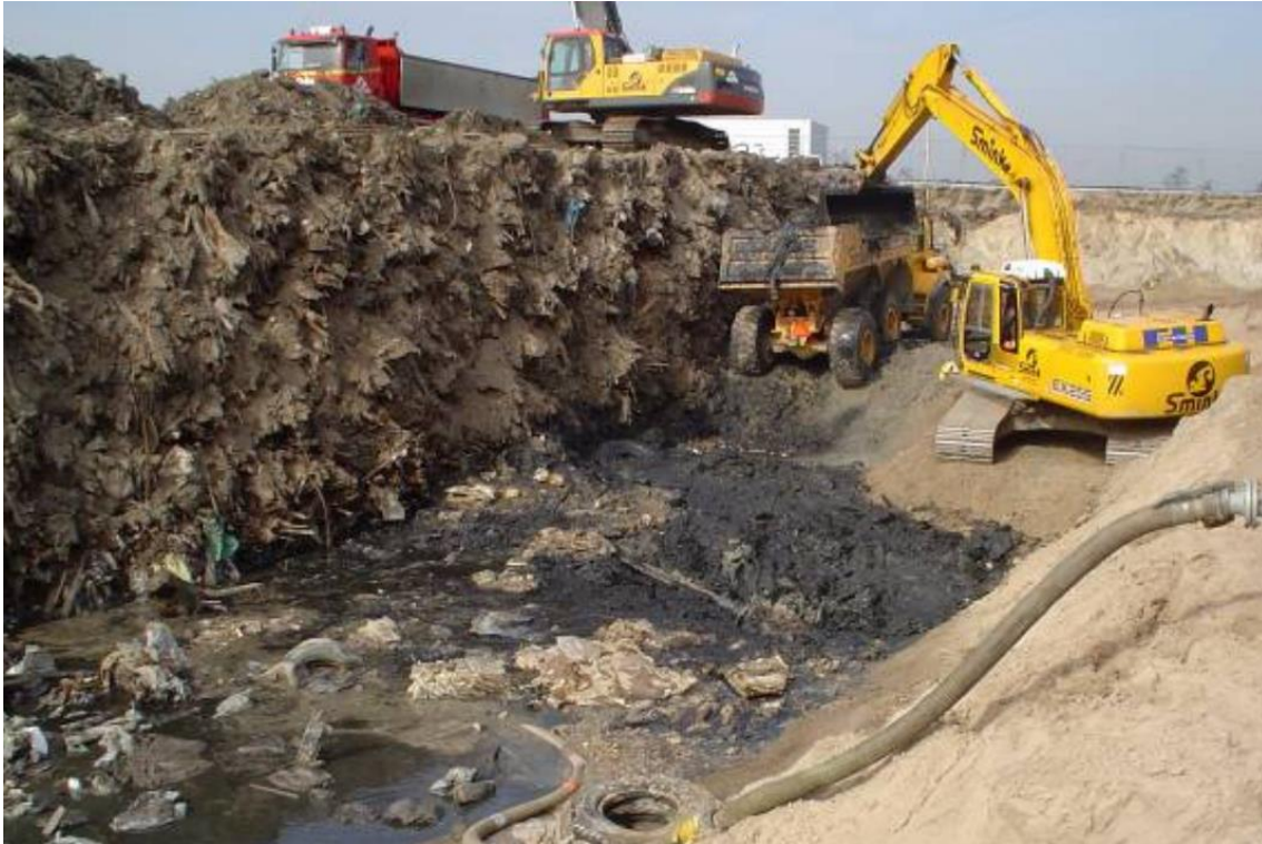
Figura 6.4 – ilustração da operação de escavação e carga de resíduos em mineração de resíduos e a bombagem dos lixiviados que se torna necessário proceder.
